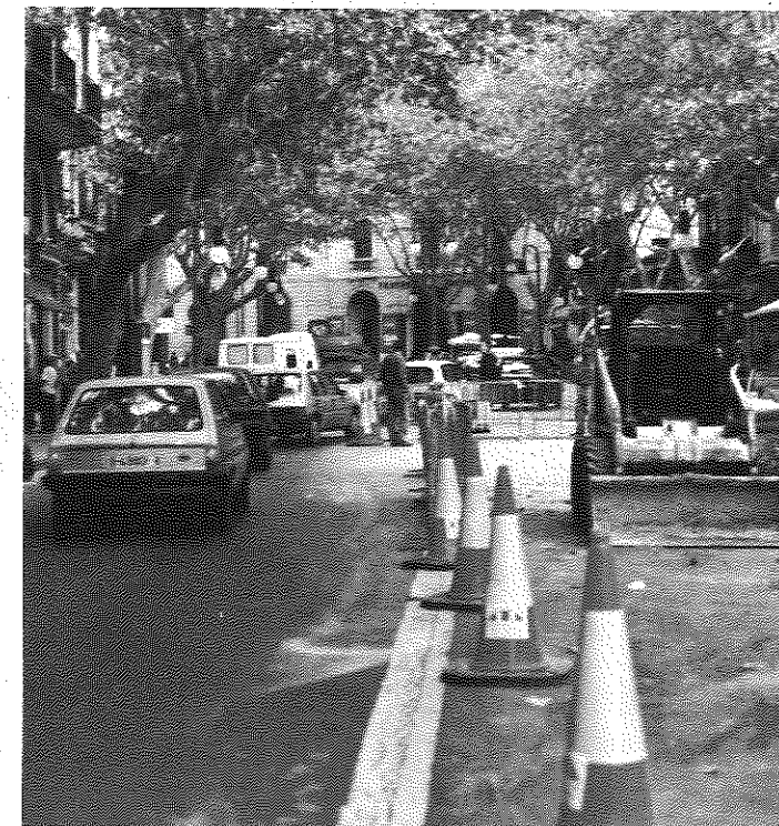
Les obres dificulten encara més la circulació dels vehicles.
